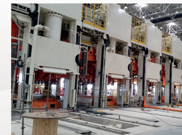
Montagem Eletromecânica de Equipamentos
