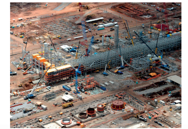
Montagem de Tanques e Subestações
