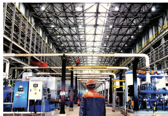
Montagem de tanques e máquinas texturizadoras.
