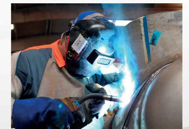
Montagem e manutenção eletromecânica da unidade gelados.
