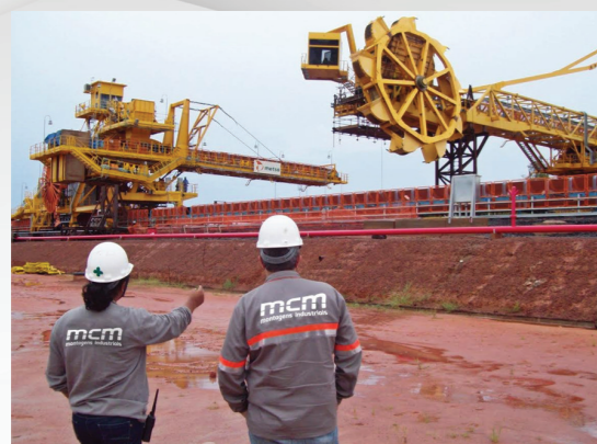
Montagem e manutenção eletromecânica da Mina de Bauxita
