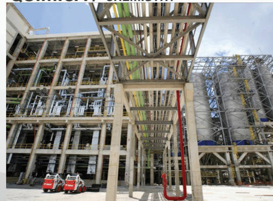
Montagem de equipamentos, tubulações e manutenção industrial.
