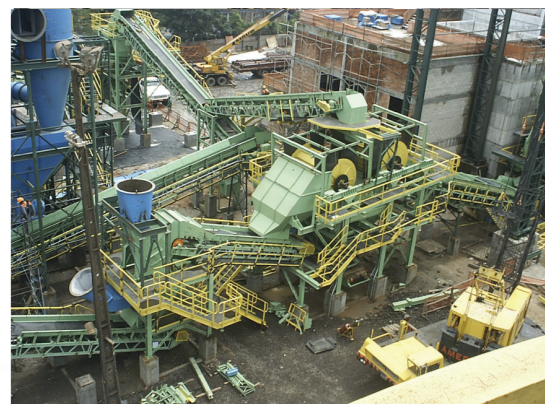
Montagem Eletromecânica de Equipamentos
