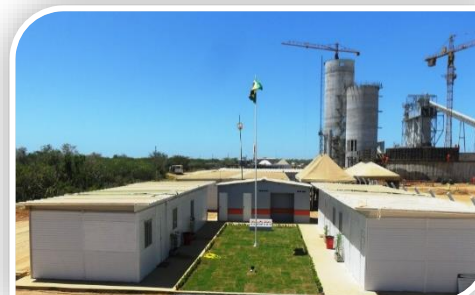
○ Canteiro de Obra
